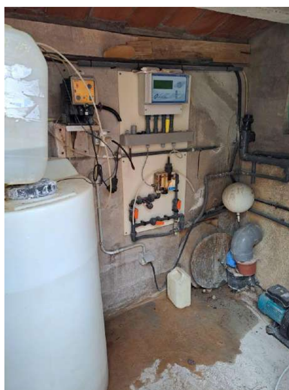
14. Caseta de cloració
