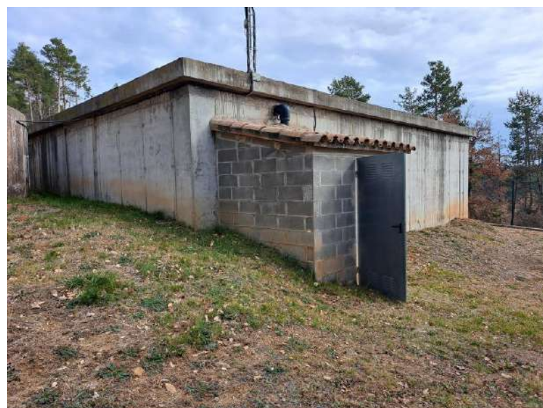
13. Caseta de cloració
