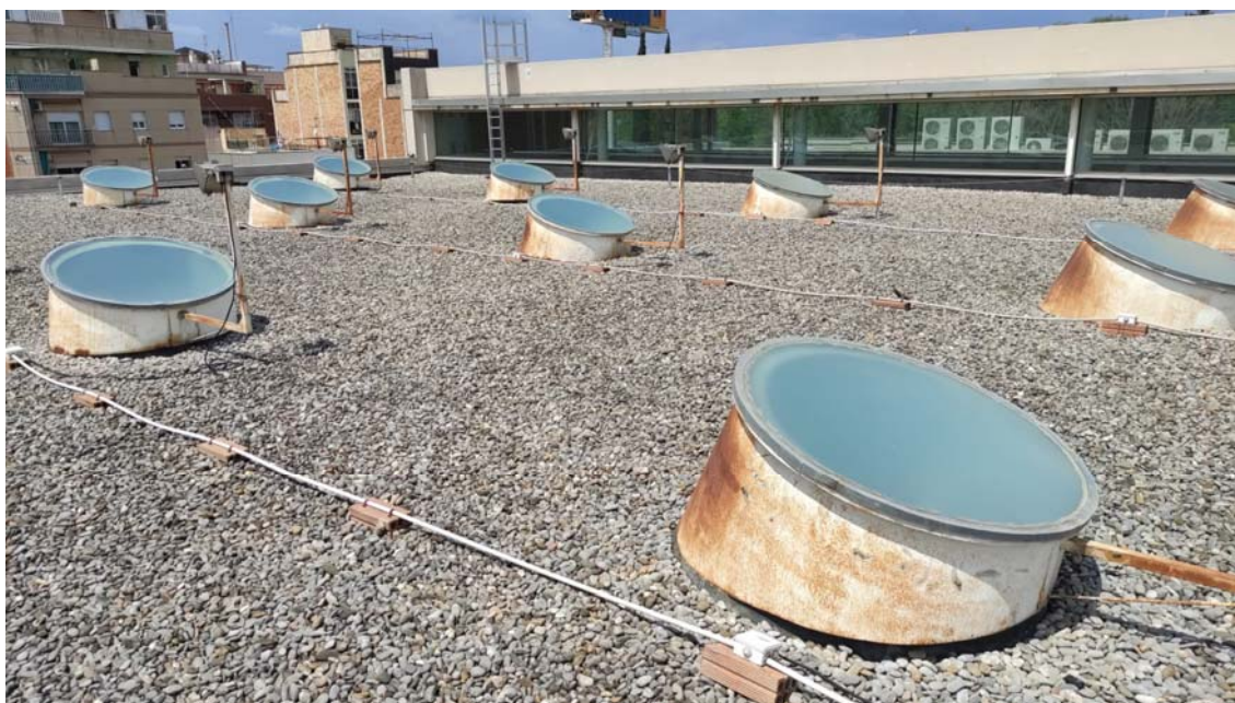
IMATGE ESTAT ACTUAL COBERTA 1
