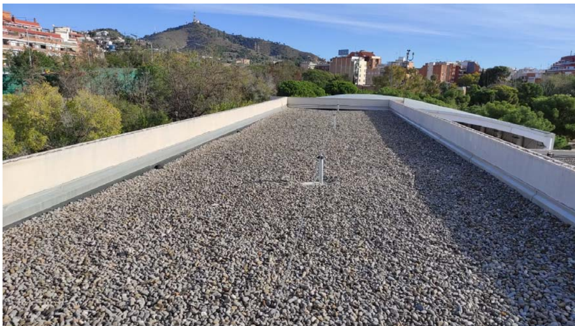
IMATGE ESTAT ACTUAL COBERTA 2
