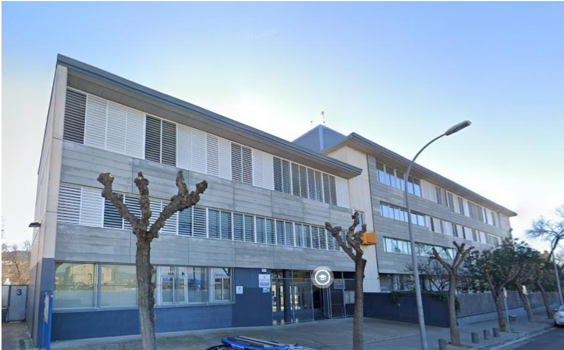
Figura 3. Edifici objecte de projecte d'obra fotovoltaica. Font: Infraestructures.cat
