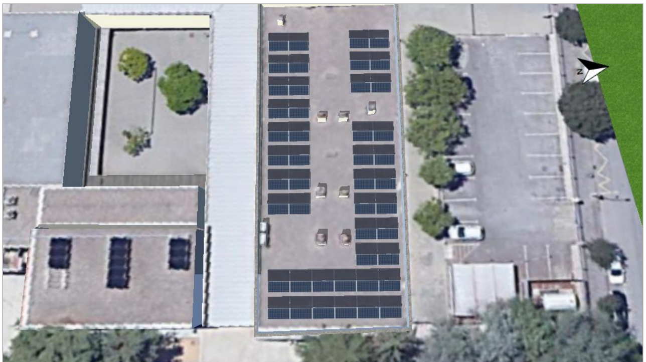
Figura: 1. Superficie fotovoltaica - Edificio a discreción 03-Superficie fotovoltaica Este
