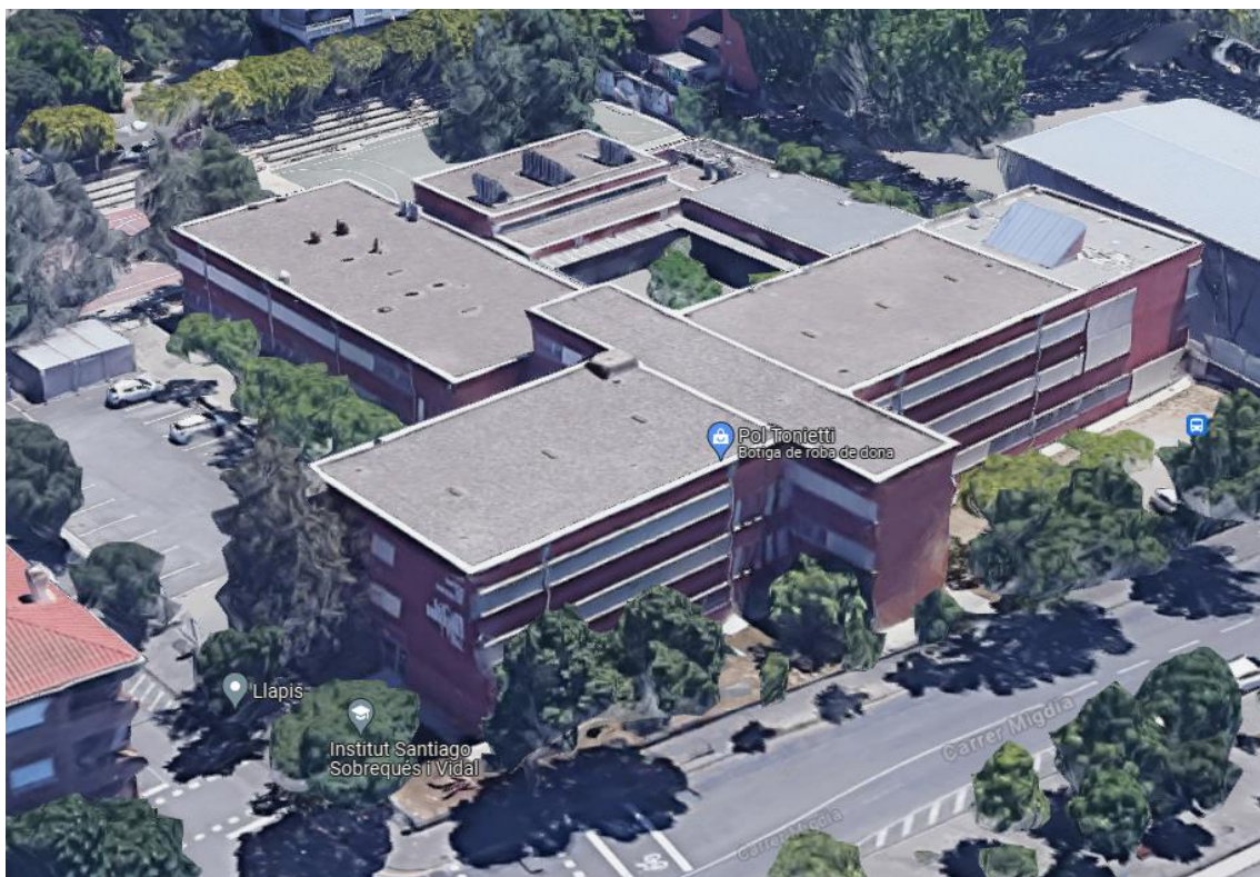
Figura 3 Edifici objecte de projecte d'obra fotovoltaica. Font: Infraestructures.cat
