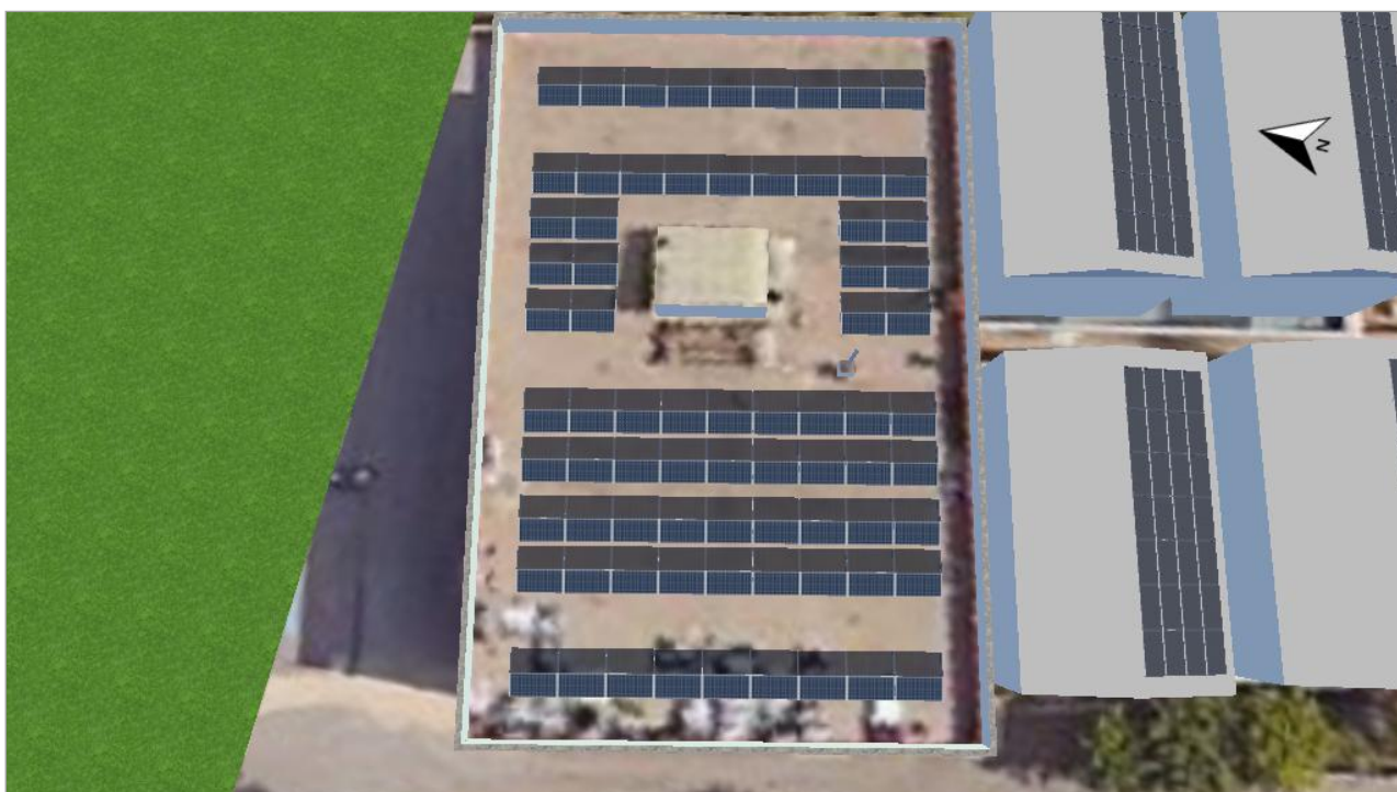
Figura: 1. Superficie fotovoltaica - Edificio a discreción 01-Superficie fotovoltaica Oeste
