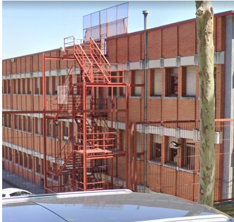
Figura 3 Edifici objecte de projecte d'obra fotovoltaica. Font: Infraestructures.cat
