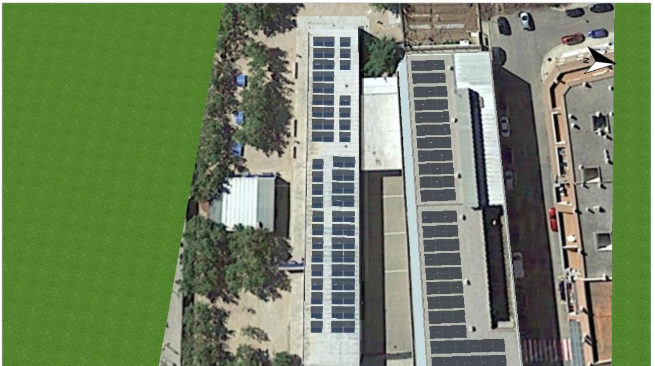
Figura: 4. Superficie fotovoltaica - Edificio a discreción 02-Superficie fotovoltaica Este
