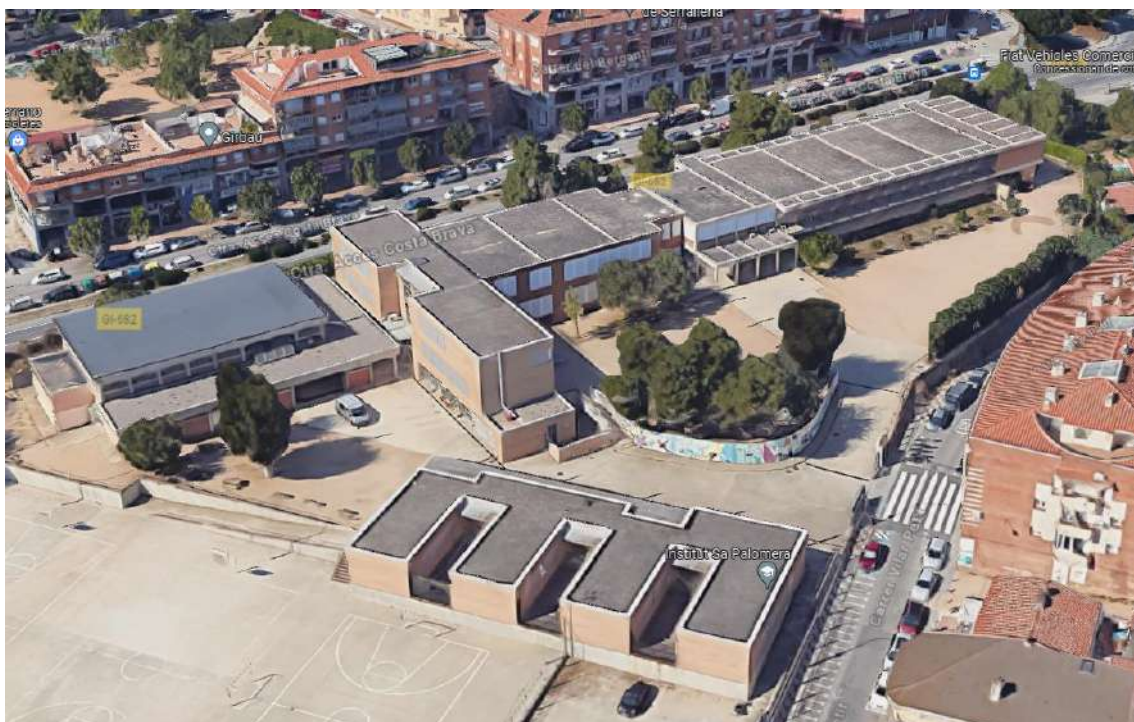
Figura 3 Edifici objecte de projecte d'obra fotovoltaica. Font: Infraestructures.cat
