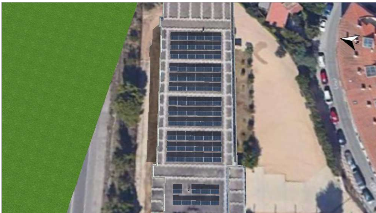
Figura: 4. Superficie fotovoltaica - Edificio a discreción 03-Superficie fotovoltaica Oeste
