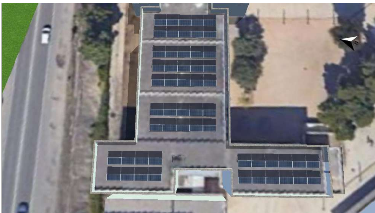
Figura: 3. Superficie fotovoltaica - Edificio a discreción 02-Superficie fotovoltaica Oeste
