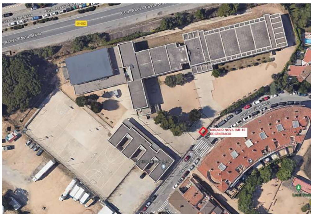
Figura 12 Retall Google Maps on es troba la nova TMF de generació. Font: Infraestructures.cat
