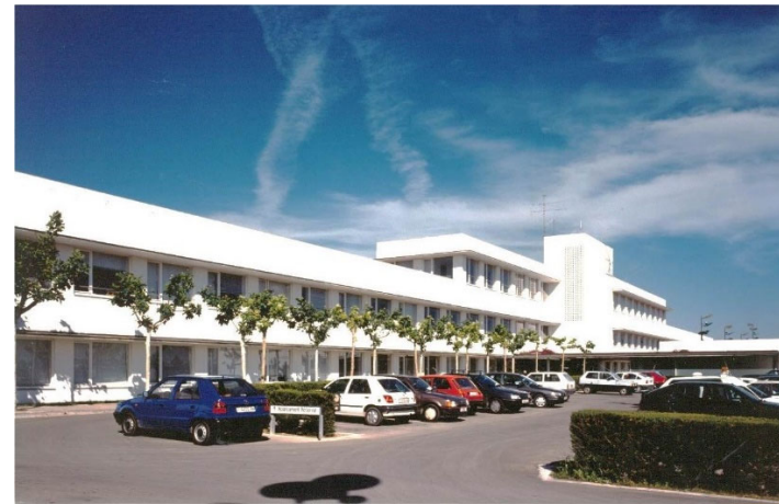
Vista accés principal
