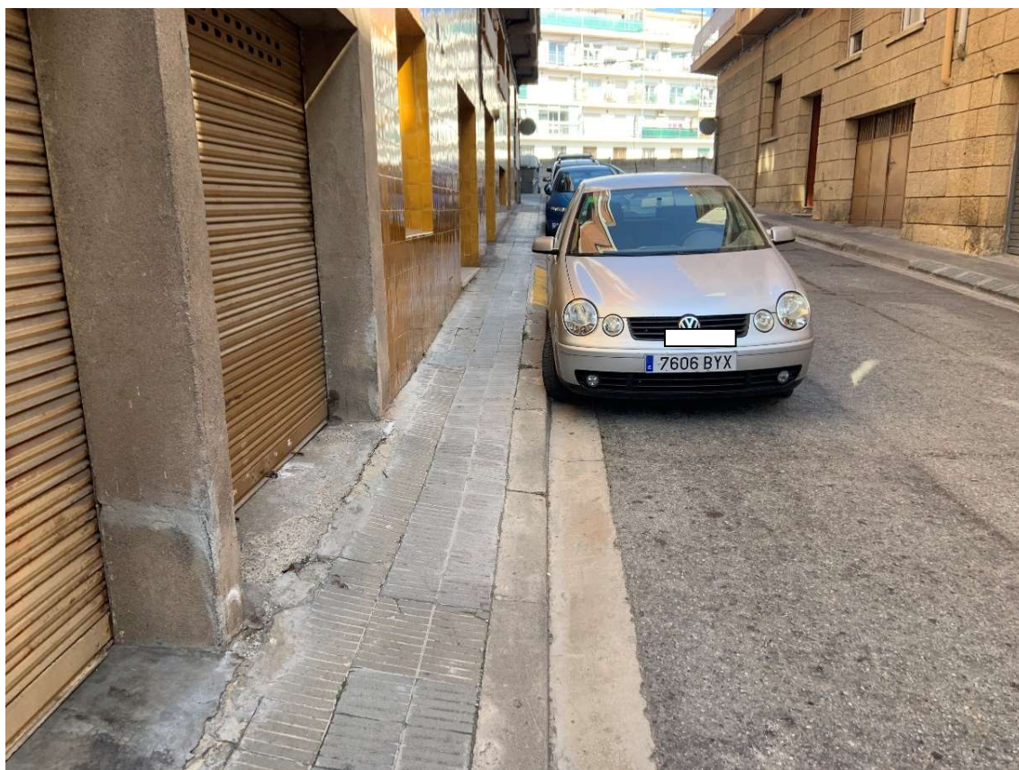
VORERA OEST DETALL DEL PANOT, LA VORADA DE FORMIGÓ I LA RIGOLA AMB DE FORMIGÓ "IN SITU"
