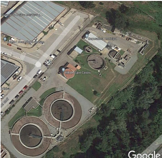
Figura 1. Vista aèria de l'EDAR Sant Celoni
