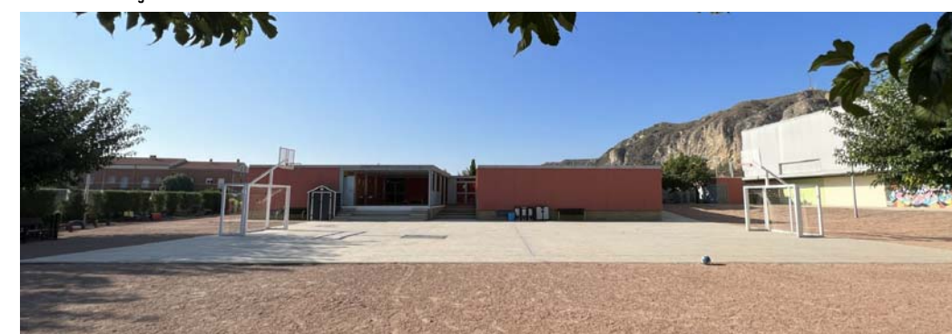
VISTA FAÇANA NORD I PATI
