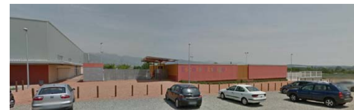
VISTA ACCÉS PRINCIPAL
