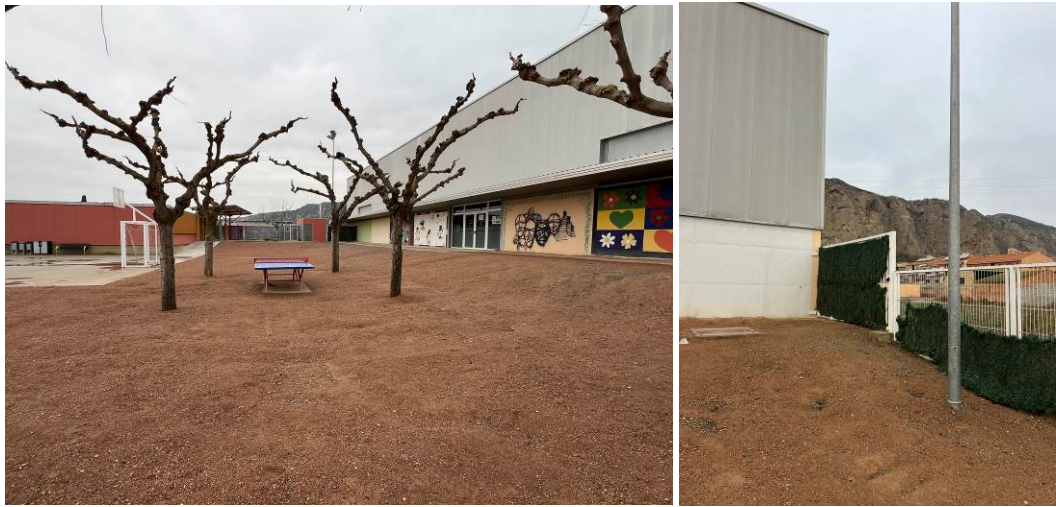
Estat actual. Vistes terraplè i desnivell entre la pista esportiva i el pavelló municipal.
