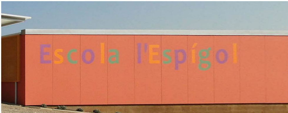
Estat actual. Retolació en vinil situada la façana principal de l'escola.
