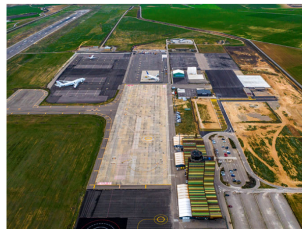
Vista frontal hangar H25-1 existent
