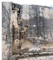
Esquerda vertical unió cantonada de carreus de pedra treballada i mur de tàpia Font: GAA 29 11 2023
