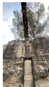
V5 Cantell interior del arc FONT: GAA 29 11 2023
