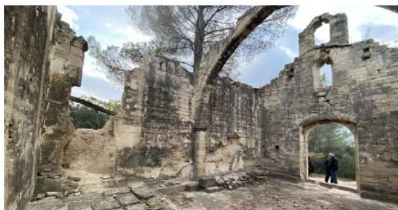
V3 Ermita de Sant Antolí vista façana interior de Migdia FONT: GAA 29 11 2023
