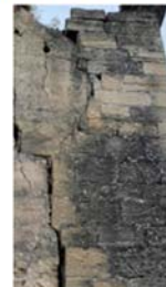
Degradació del mur de tàpia en el coronament i en la base del mur. Esquerdas verticals en la trobada de la tàpia amb la cantonada de carreus. Ennegriment dels paraments, presència de líquens i fongs. Font: GAA 29 11 2023
