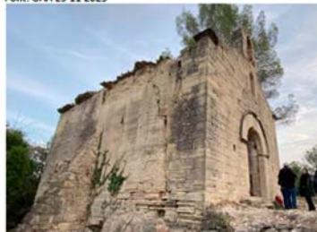
Degradació del mur de tàpia en el coronament i en la base del mur. Esquerdas verticals en la trobada de la tàpia amb la cantonada de carreus. Ennegriment dels paraments, presència de líquens i fongs. Font: GAA 29 11 2023
