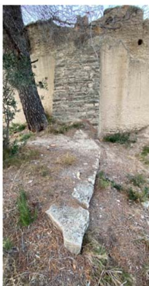
L'arbre a tocar de la base de l'ermita. Patologies derivades de les arrels en la base del mur Font: GAA 29 11 2023
