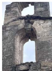
V8 Vista obertura façana ponent FONT: GAA 29 11 2023
