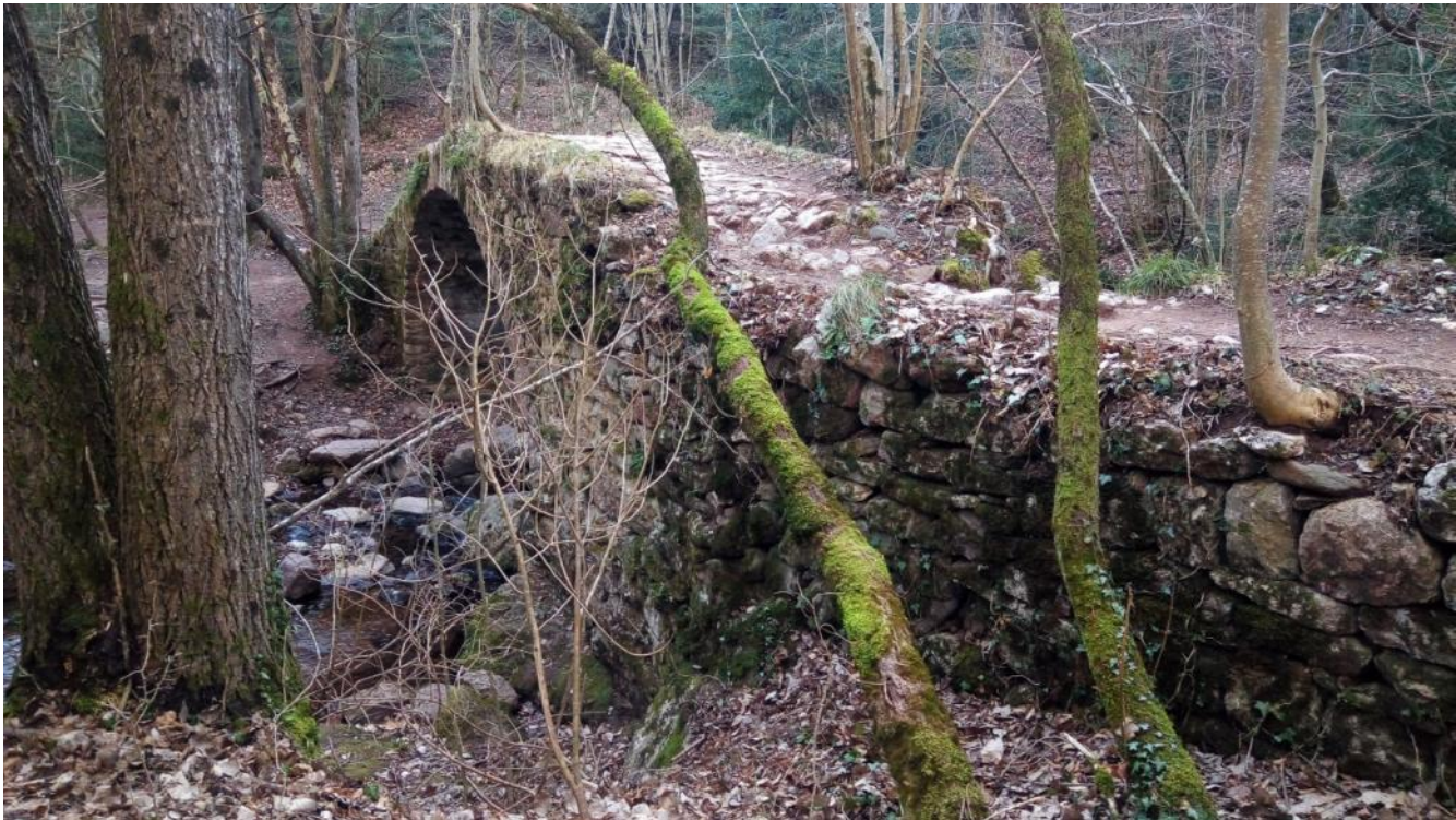
Fotografies del tauler amb el paviment de còdols vist des dels dos costats, i vista de la façana aigües amunt . Foto: Antoni Barcons, arxiu SPAL, 2022 (Fotografies extretes de l'Avantprojecte de Consolidació del Pont del Molí de les Fonts Maig 2022)
