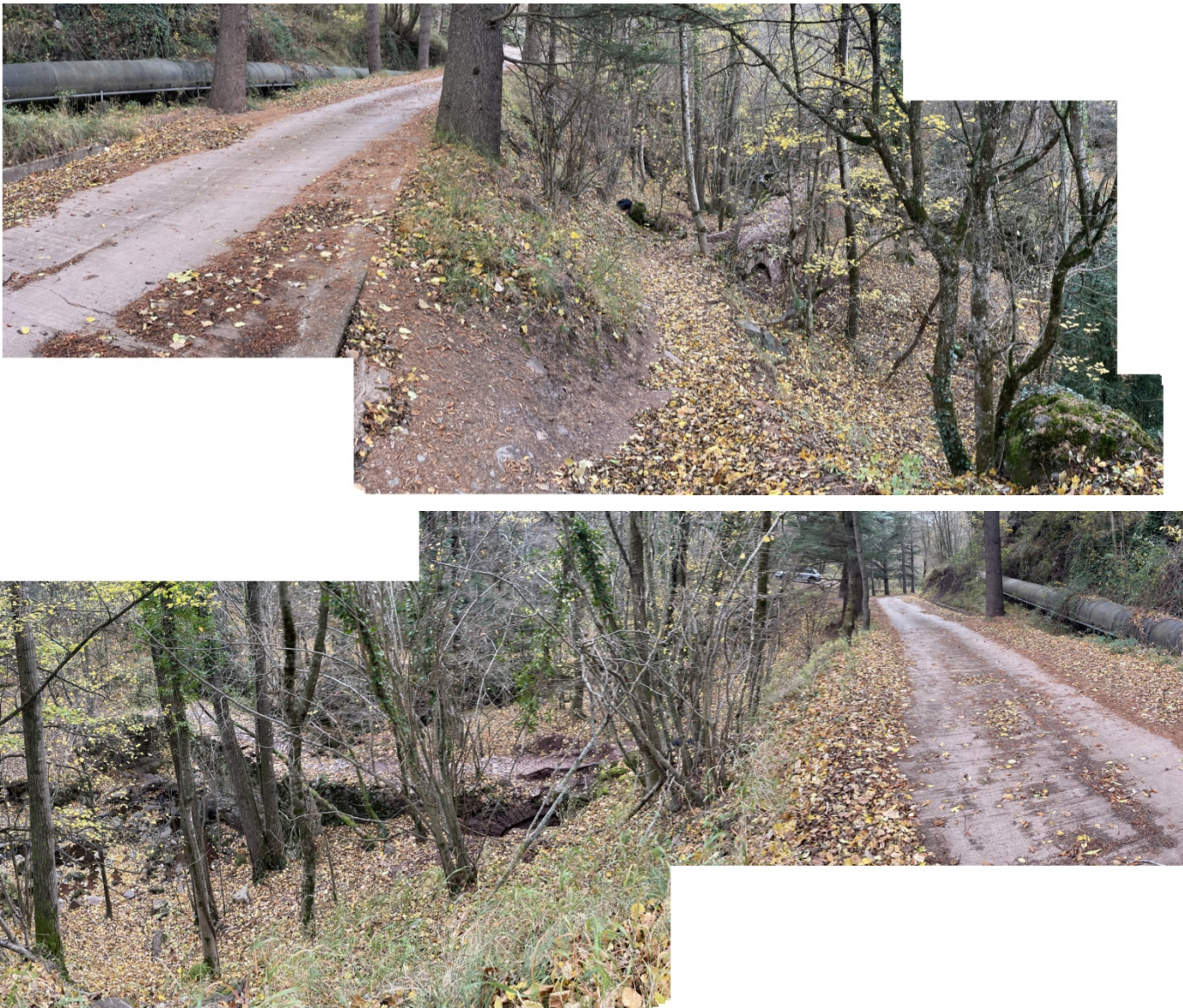
El pont des de la carretera d'accés amb el camí que davalla fins l'estrep de pont.
