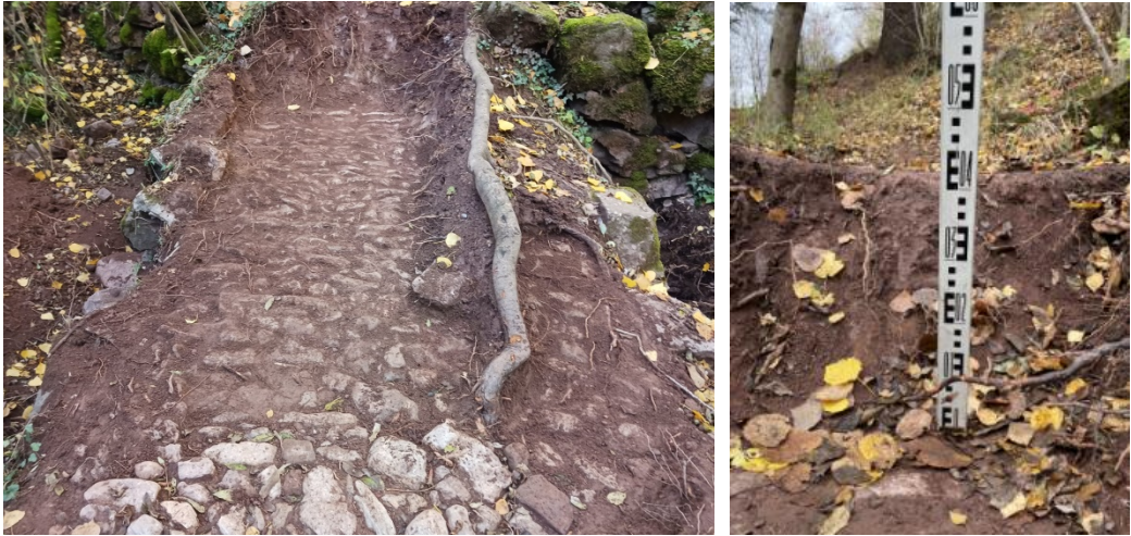
Terres excavades a l'estrep de ponent on caldrà completar l'excavació i adequar l'entorn
