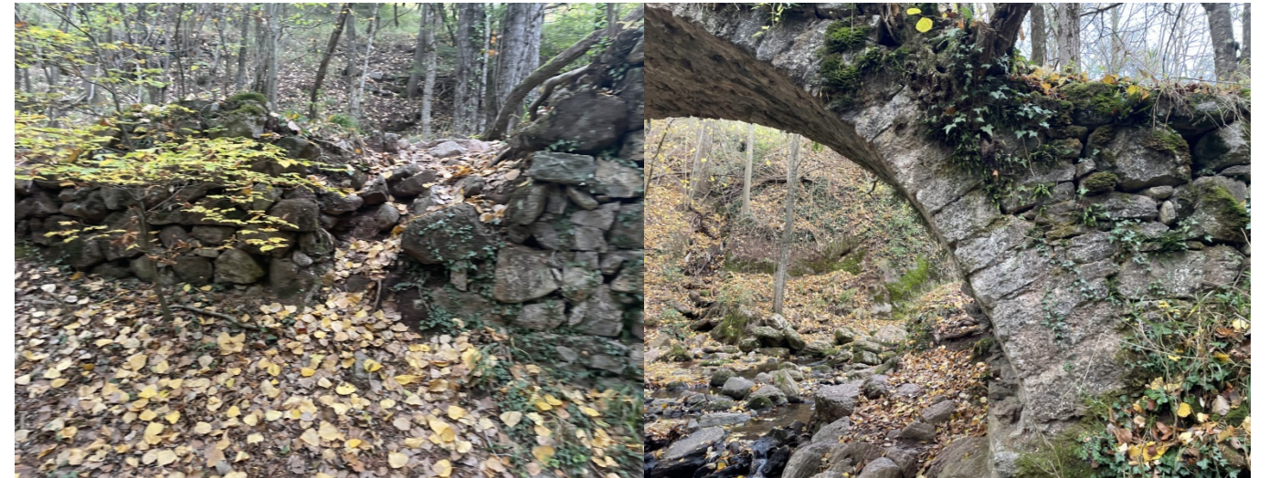
Parts esfondrada aigües avall (part central entre ulls i estrep llevant)
