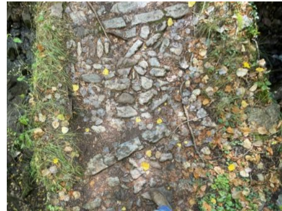
Detall del paviment a la vista sobre l'arc principal, i el descobert en les prospeccions arqueològiques a l'estrep de ponent
