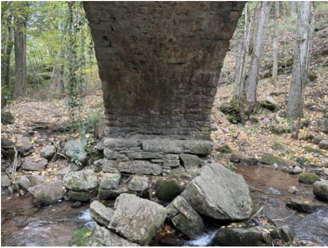
La volta: vistes i detalls de l'intradós i estreps
