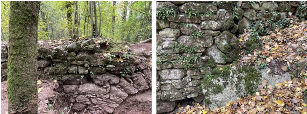
Paraments amb presència de molses i restes orgàniques que cal eliminar
