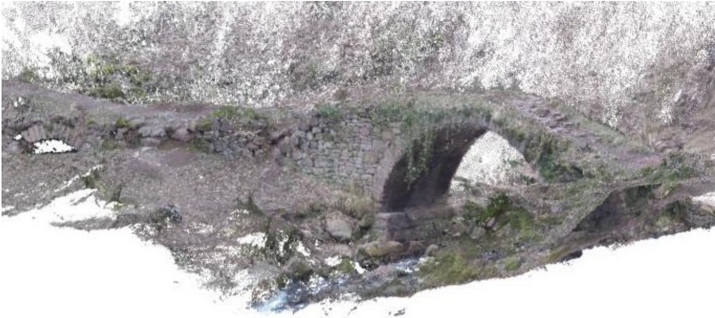
Modelització de l'estat inicial del pont i l'entorn vist des de llevant, generat a partir del núvol de punts georeferenciat realitzat pel servei de topografia de l'SPAL
