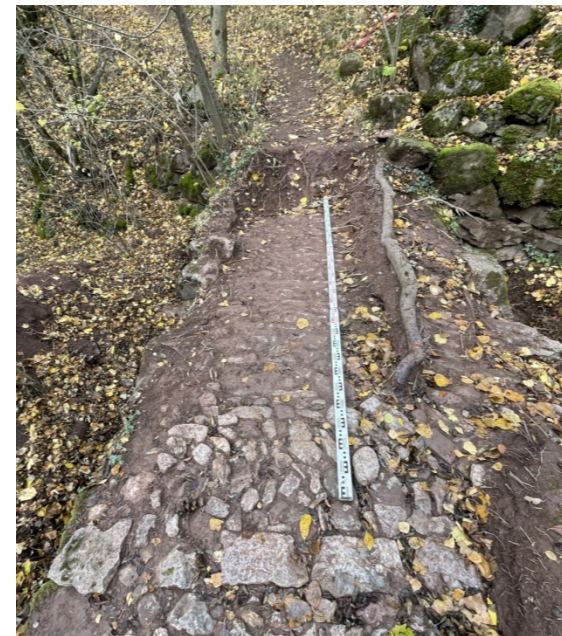
Tram de paviment original destapat a l'extrem de ponent del pont ocult sota una gruixuda capa de terres
