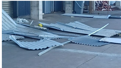
Elements de la coberta arrencats pel vent.
