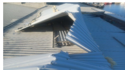
Trams de coberta en procés d'arrencament durant la ventada.
