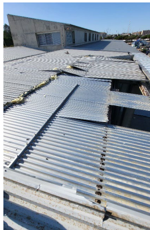
Elements de la coberta arrencats pel vent.
