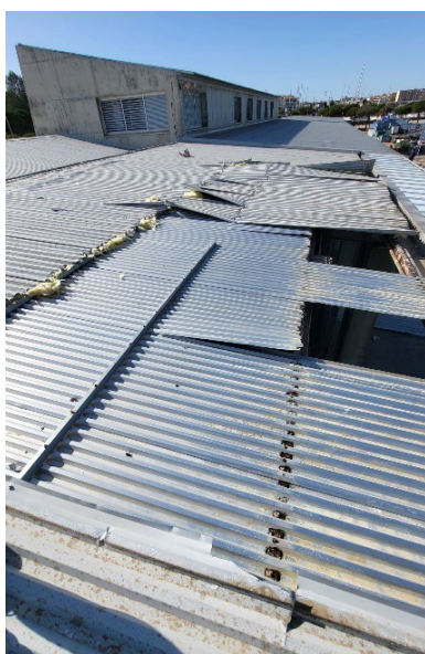
Elements de la coberta arrencats pel vent.
