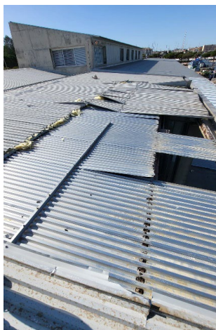
Elements de la coberta arrencats pel vent.
