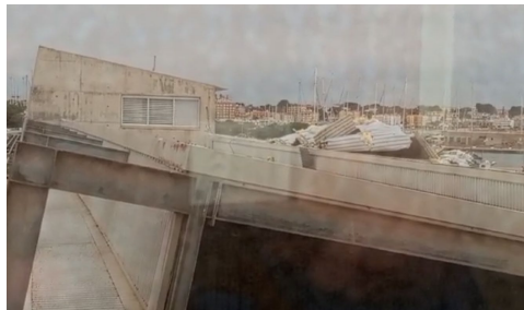
Trams de coberta en procés d'arrencament durant la ventada.
