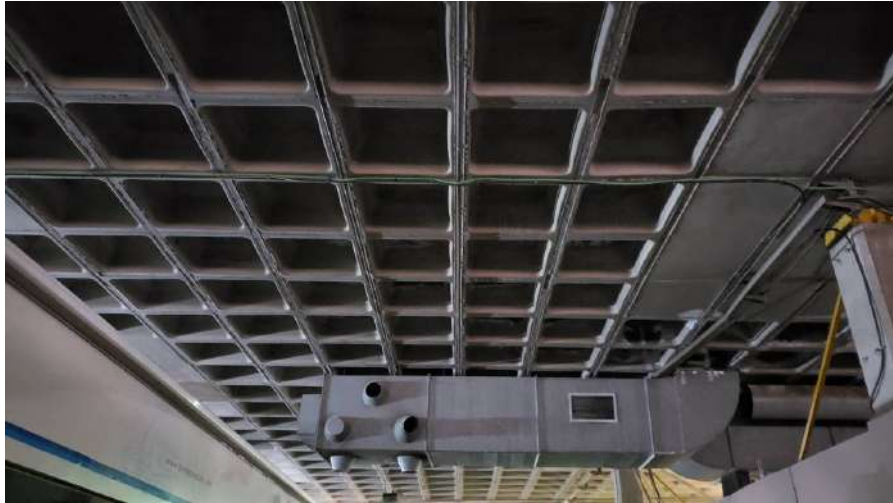
Forjat sostre planta primera en zones sense humitats
