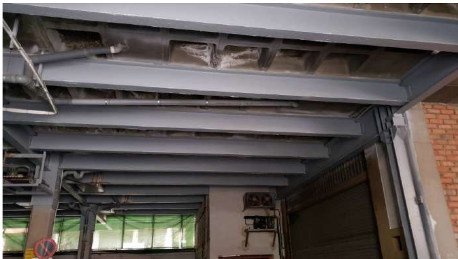
Reforç metàl·lic interior sostre planta baixa
