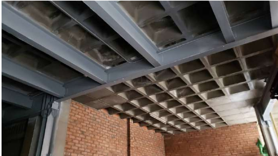
Reforç metàl·lic interior sostre planta baixa
