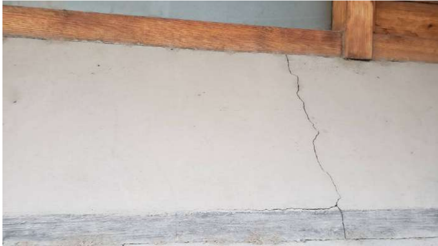
Fissuresjàssera altell oest exterior
