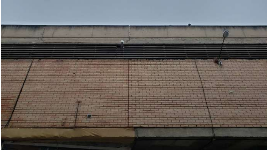
Junta dilatació façana nord
