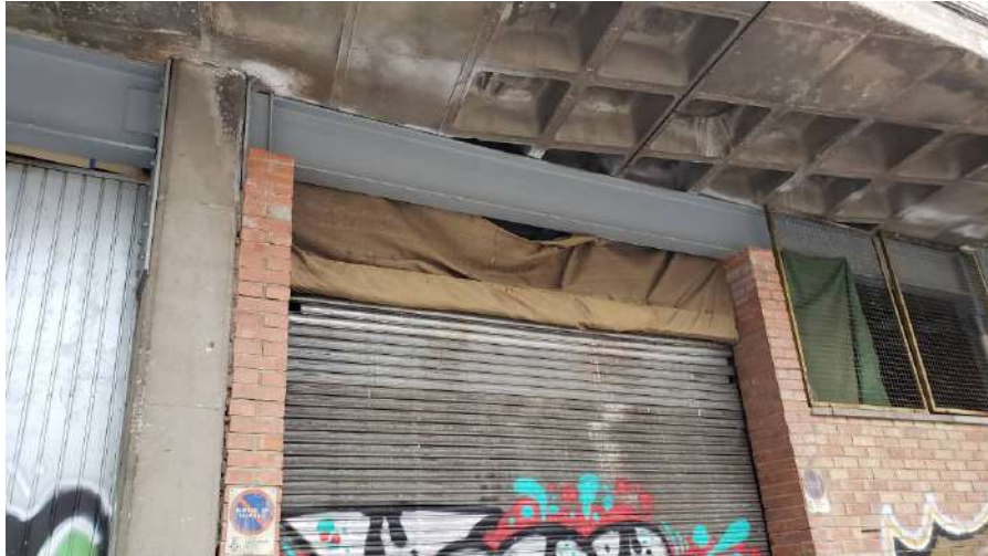
Reforç metàl·lic sostre planta baixa zona sud
