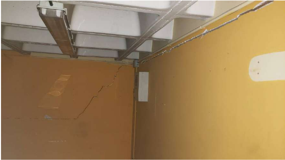
Trencament d'envans altell oest local Ajuntament per flexió forjat altell i sostre planta baixa
