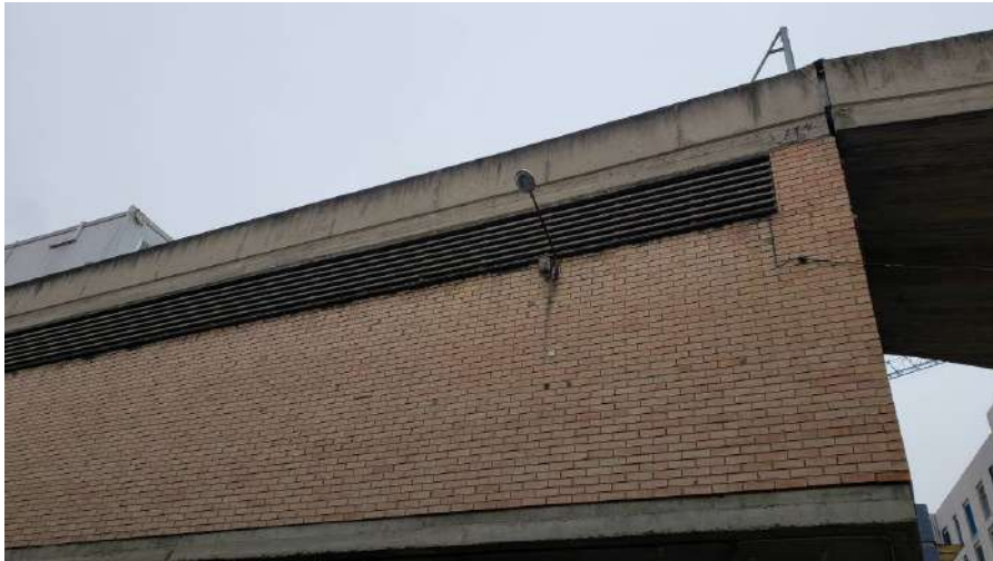
Junta dilatació rampa cotxes-façana nord
