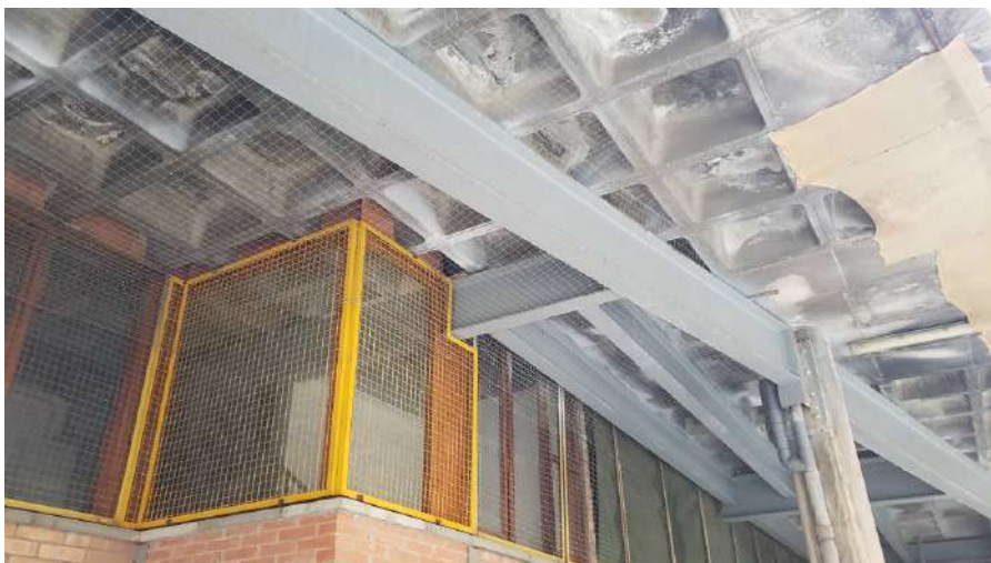
Reforç metàl·lic sostre planta baixa zona nord exterior
