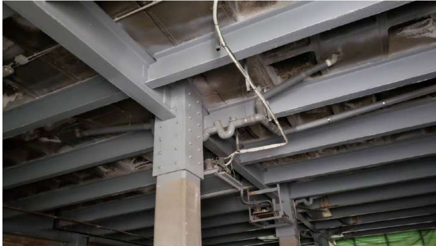
Reforç metàl·lic interior sostre planta baixa
