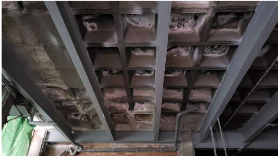
Reforç metàl·lic interior sostre planta baixa
