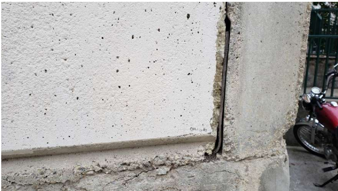
Detall làmina rampa de vianants est primer tram reparat
