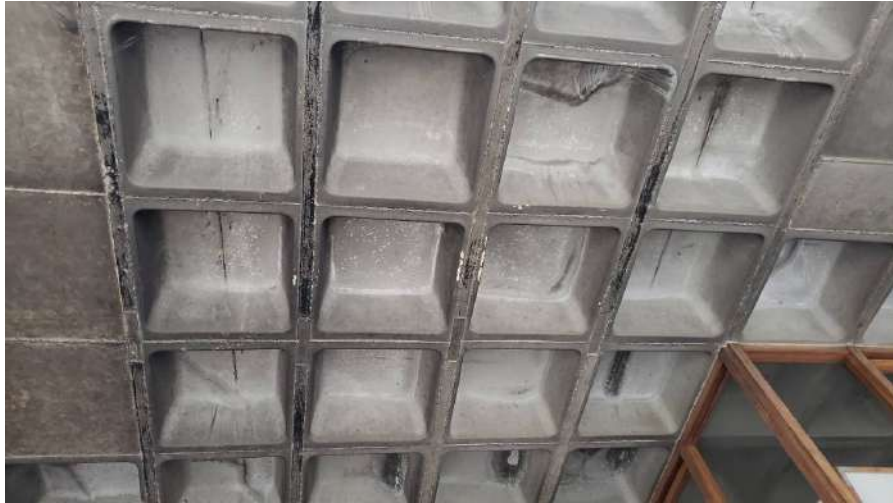
Armatures sense recobriment zona exterior sostre planta baixa
