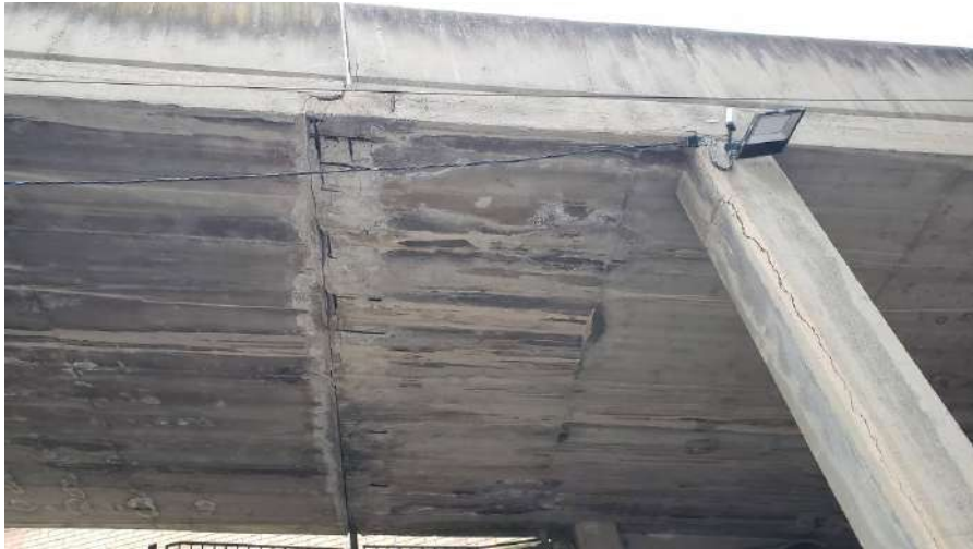
Oxidació armat longitudinal pilars rampa cotxes oest en al seva totalitat
