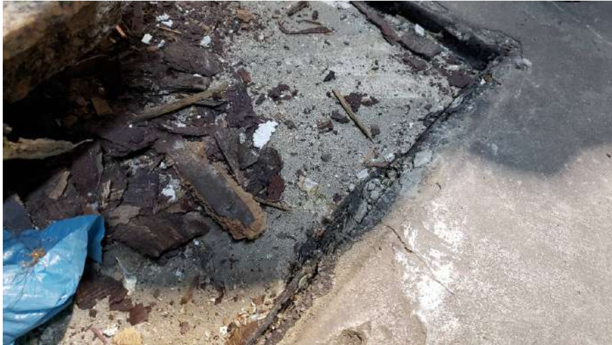
Làmina impermeable zona canal parades
