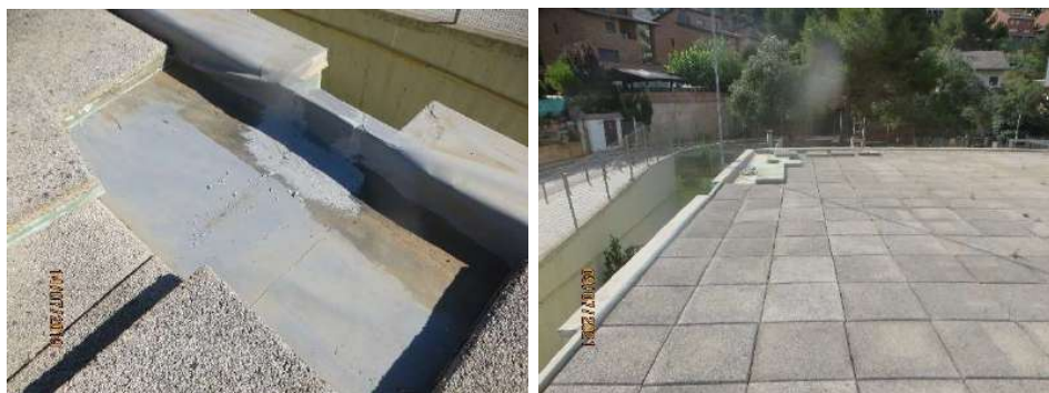
Fig. 3 i 4- Reparacions efectuades a la coberta amb pintures i massilles impermeabilitzants el juliol de 2021
