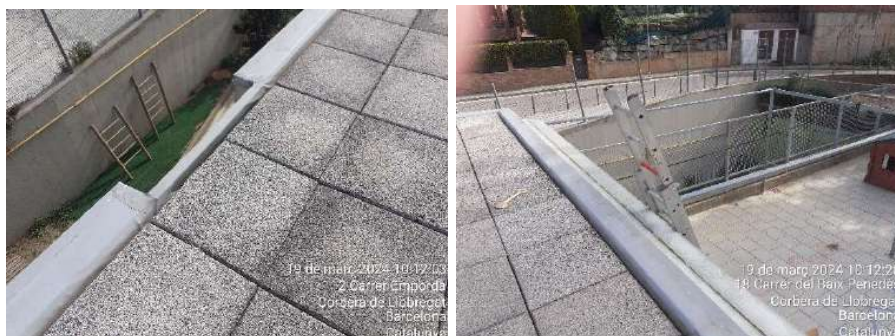
Fig. 8 i 9– Panells metàl·lics en el muret lateral per col·locació de baranes de protecció col·lectiva
