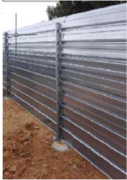
TANCA PROVISIONAL D'OBRA
