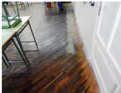
Imatges del paviment substituït. Font: Arquitectura Genís Planelles.
