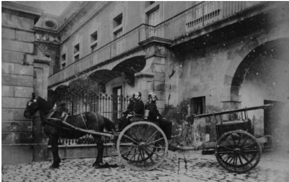
F13. Imatge de començament segle XX en la qual es constata la presència d'estucs decoratius i d'emmarcaments també per a les finestres i portes que donaven al pati interior de l'edifici. Font. ANC. Fons Fotogràfic.
