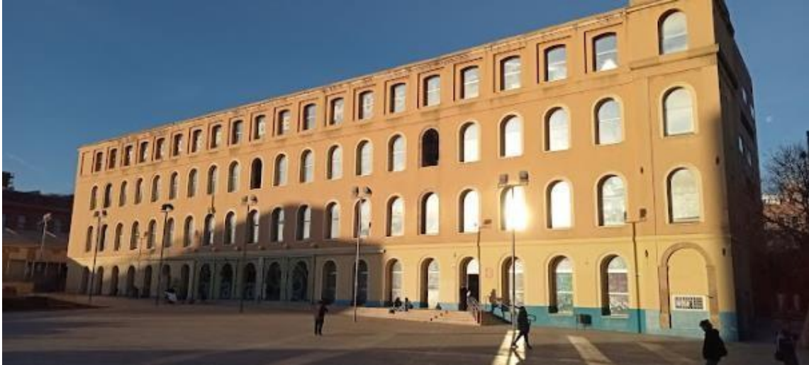
Imatge 1. Imatge de la biblioteca Ignasi Iglésias, edifici objecte de projecte.
