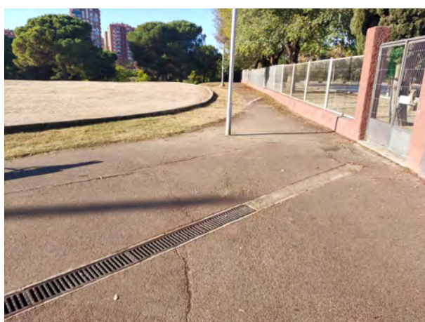
Reixa interceptora davant l'IE Llibertat , on es connectarà la nova font
