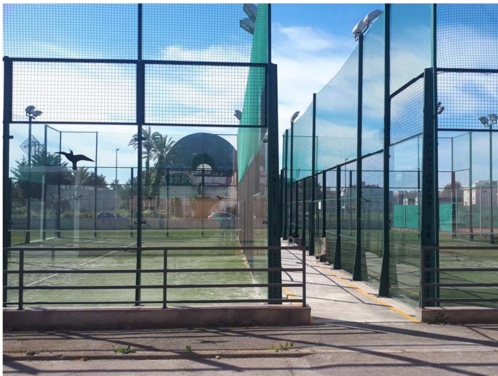
Passadís central existent
