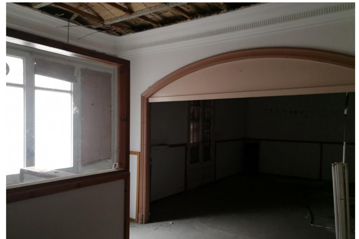
Estat actual espai interior planta segona
