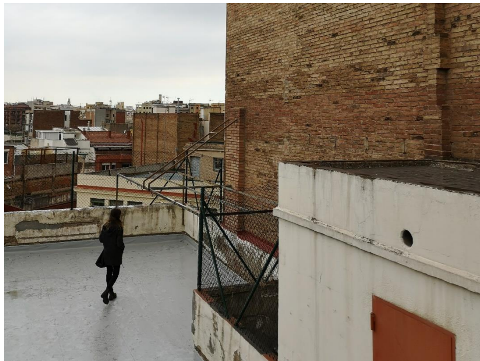
Coberta i mitgera nord amb veí
