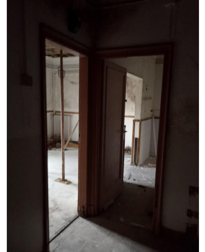
Espais interiors apuntalats (2)
