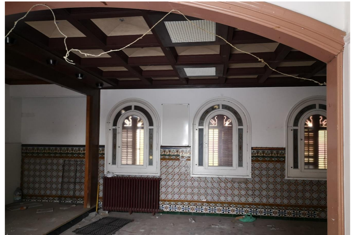
Estat actual espai interior planta primera
