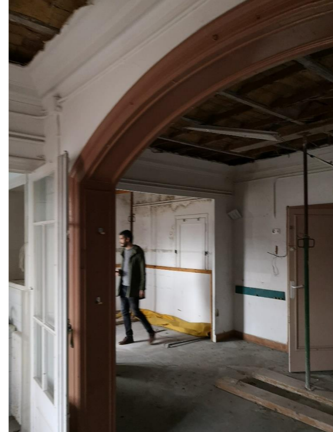
Espais interiors apuntalats (1)
