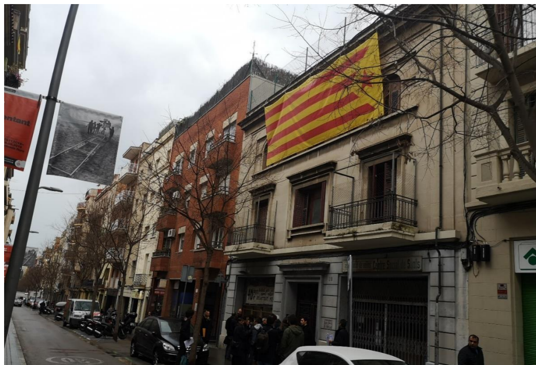
Estat actual façana principal
