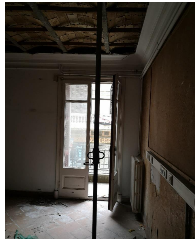
Espais interiors apuntalats (3)
