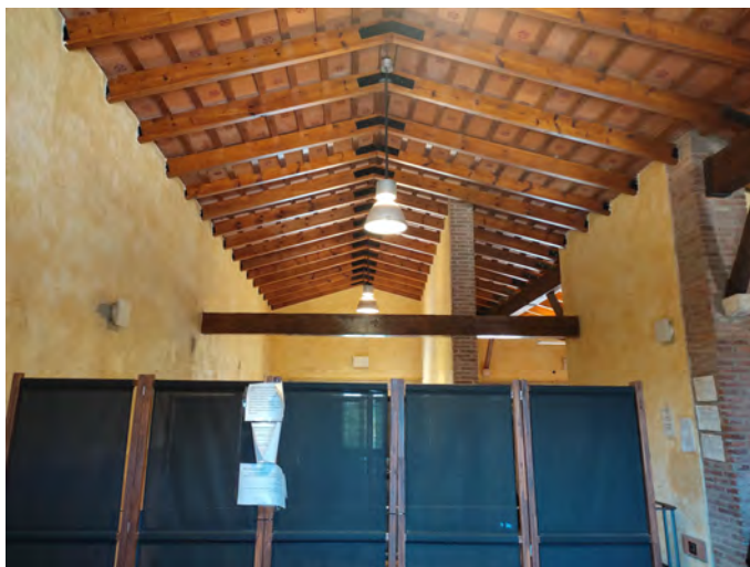
Jàssera sota la qual es col·locarà el nou tancament dels dormitoris 3 i 4 (P1)
