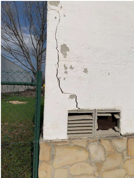
Esquerdes i reixes a substituir
