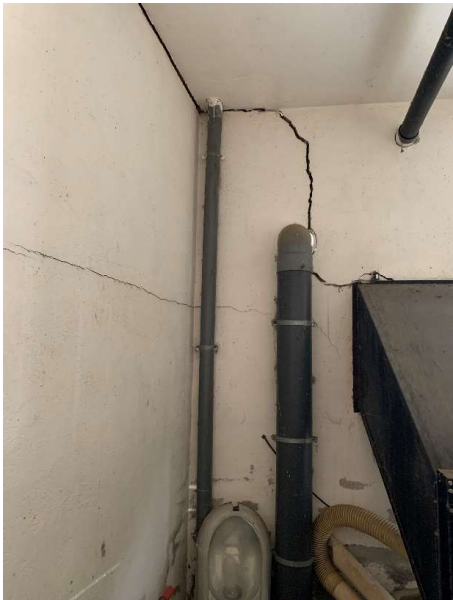
Esquerdes i reixes a substituir
