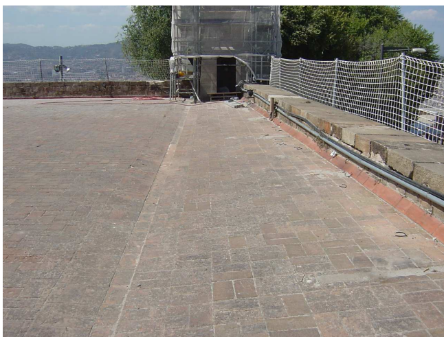
Vista d'un tram de la coberta abans d'iniciar-se la intervenció.
