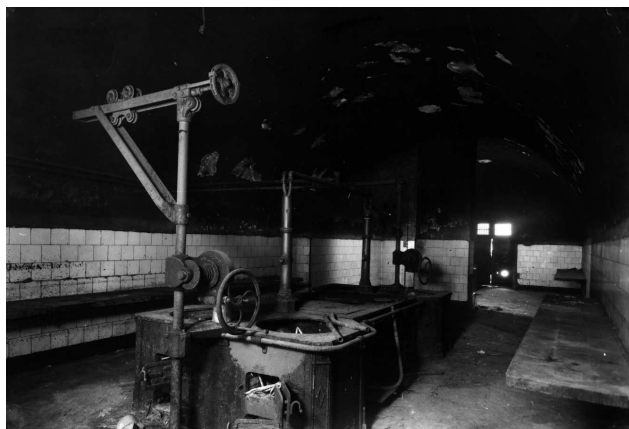
Detall d'una cuina que hi havia segurament a la sala 15 abans de les obres del Museu Militar.
