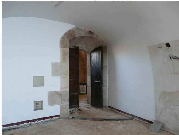
Vista de la porta d'una de les sales de la banda de mar. S'observa com la posició de la porta està forçada respecte a la volta
