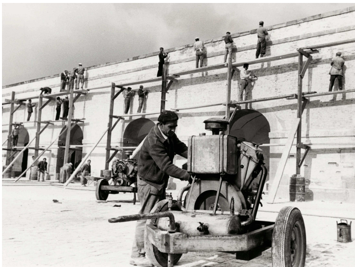
Vista dels treballs de repicat de parets que es van portar a terme a començament dels anys 60 per la transformació del primer recinte en Museu Militar.
