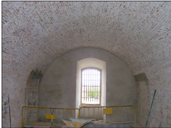
Detall de la volta d'una de les sales construïdes en el marc de la reforma del segon terç del segle XVIII.
