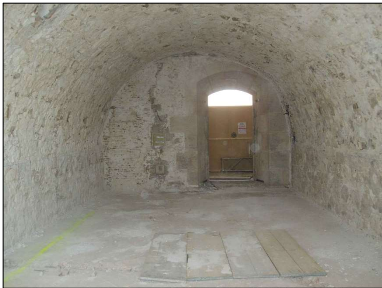
Detall d'una de les sales de la banda de mar que correspon, a excepció de la paret davantera on hi ha la porta, al fortí original.
