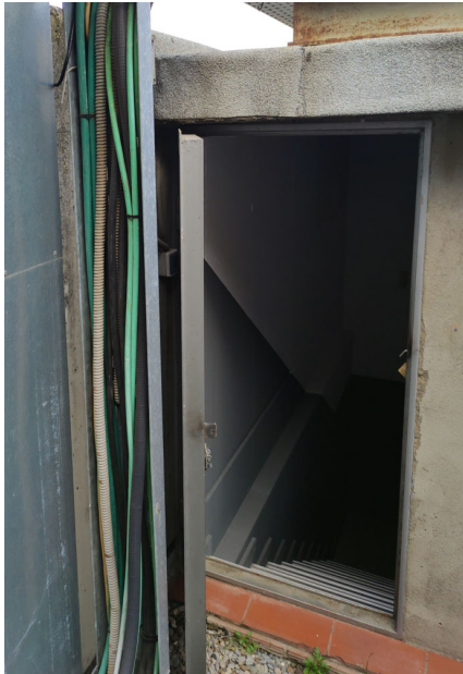
Figura 6. Escala d'accés a coberta.
