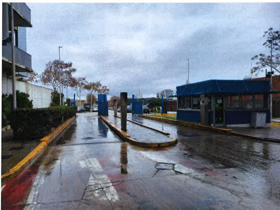
Foto 1: Àmbit zona entrada planta i cabina de control
