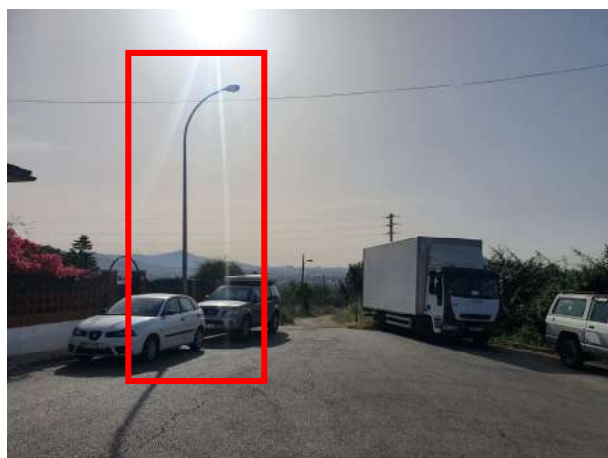
Fanal origen de la nova instal·lació en la confluència del carrer del Nord amb el carrer de Pablo Picasso
