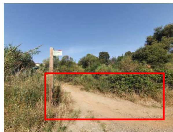
Empalitzada a mig camí
