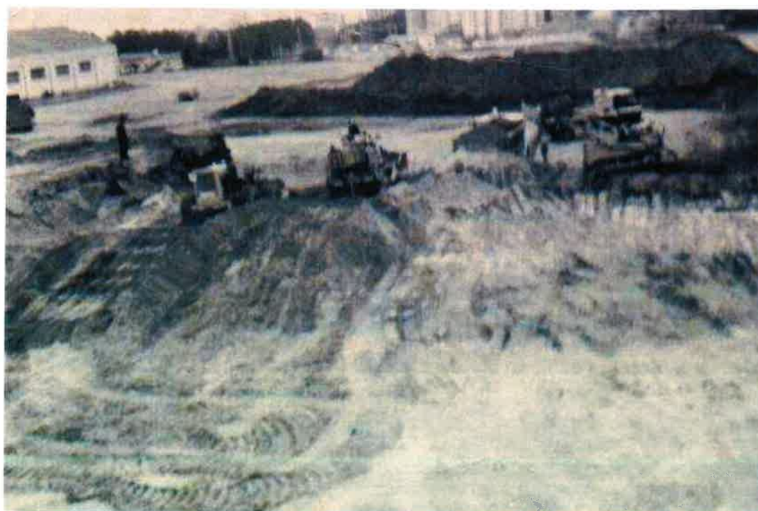
Imatges cedides per Joan d'excavacions lluro, dels rebaixos efectuats als setanta del segle XX per l'ampliació de la fàbrica Cristalleries Mataró, efectuats pel seu pare.
