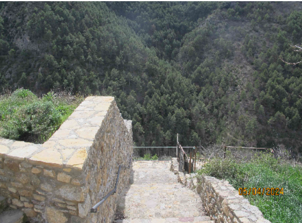
4.-Escalaes i mur de tancament
