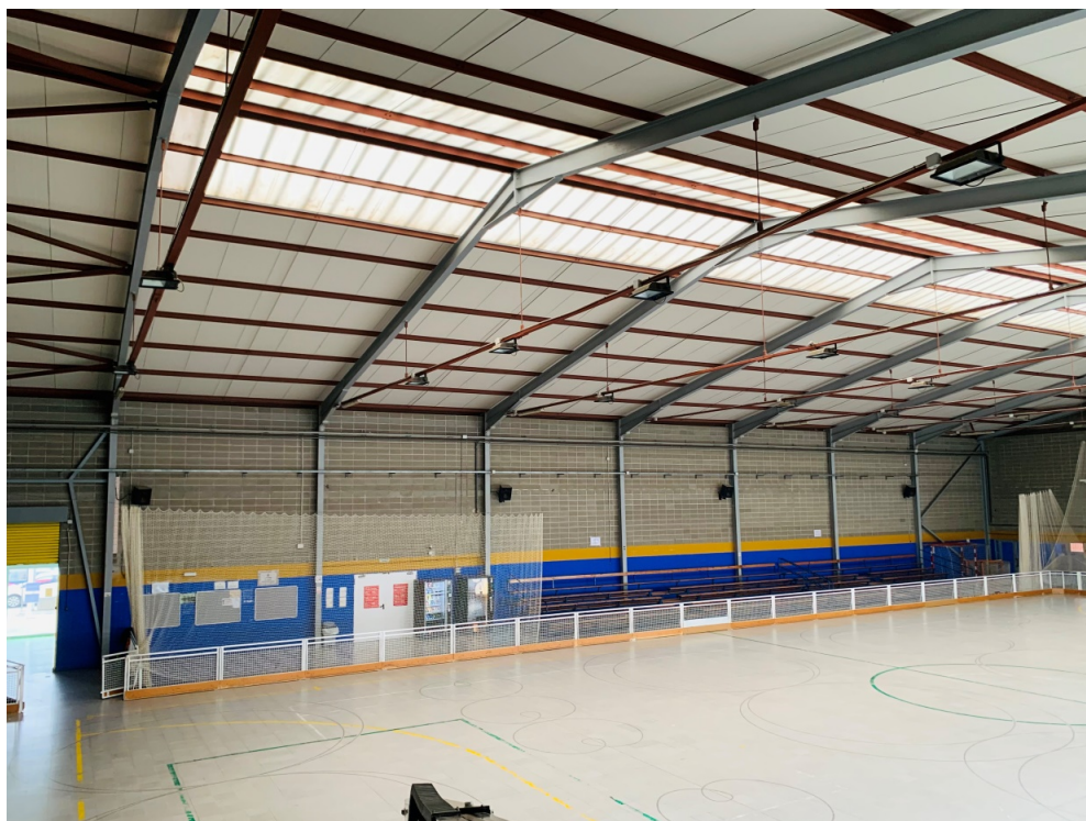
Fotografia 3: interior del pavelló
