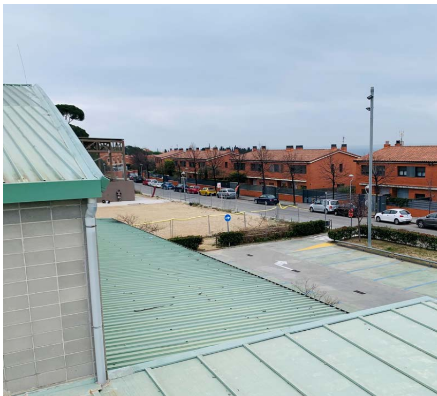
Fotografia 4: Coberta zona vestidors
