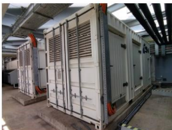
FIG. 5 Grups electrògens FDJ i esquema elèctric quadre general GE
