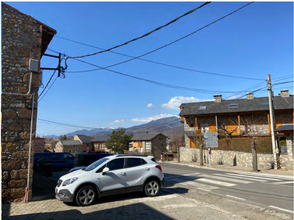
Fotografia 6. Traçats instal·lacions aèries.
