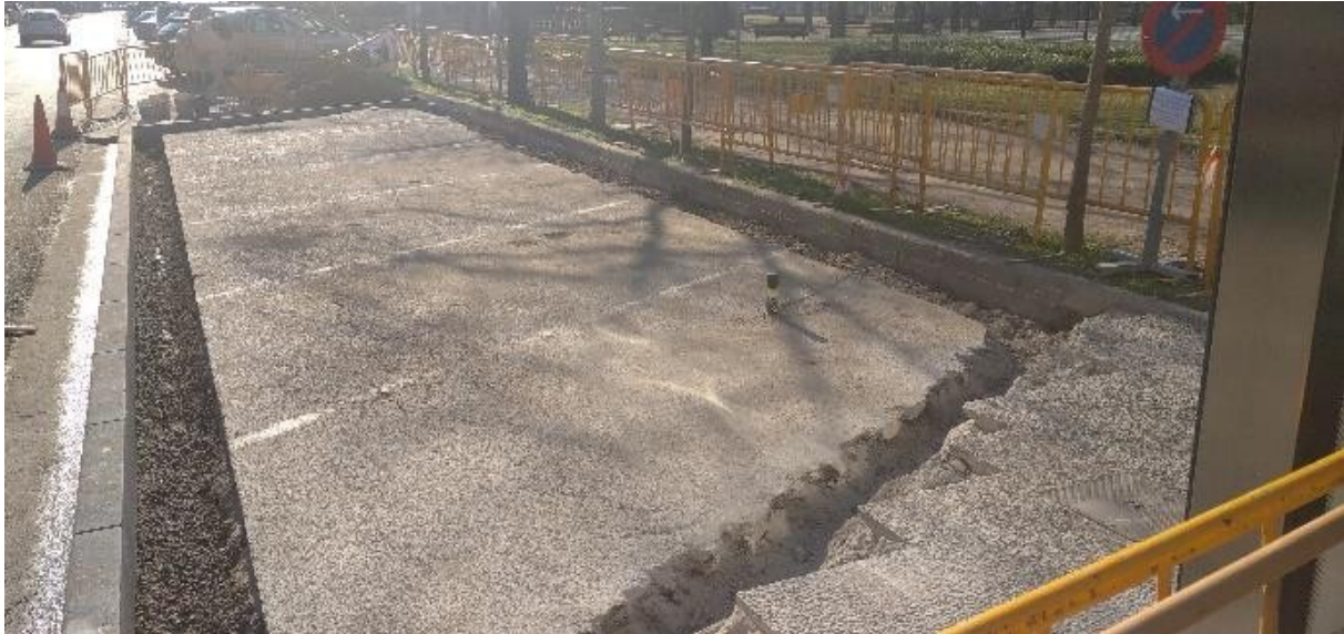
Execució de la rasa
