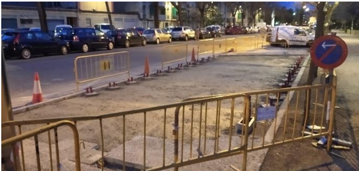
Platinas anivellades i perfectament ancorades pendent de reposar el paviment
