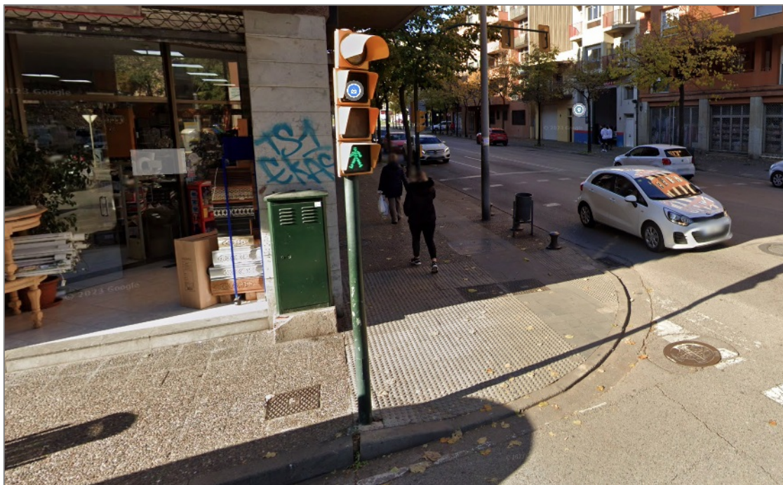
Imatge 26: Detall ubicació quadre GI 315 encreuament Passeig d'Olot C/ Agudes, cantonada sud-oest.
