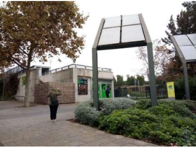
Vista general exterior: accés lateral i coberta
