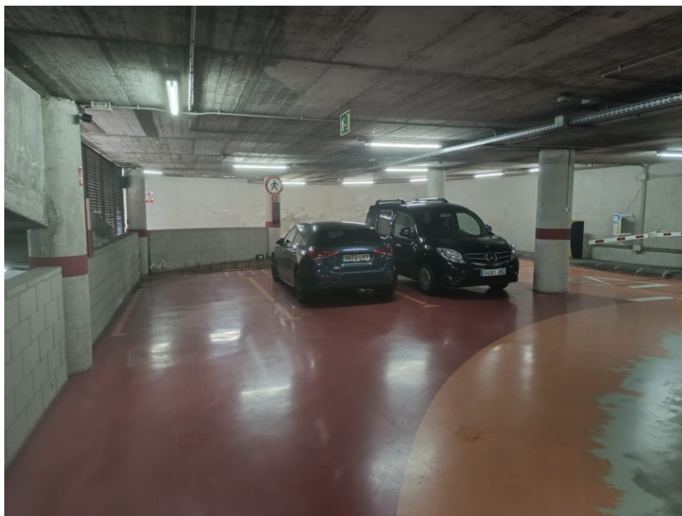
Imatge 5: Vista de les 3 places de la planta -1, a reconvertir, afectades per la previsió de conversió a 2 places exclusives per a la recàrrega de vehicles elèctrics. Detall de les columnes adjacents a la rampa per a la possible ubicació dels carregadors.
