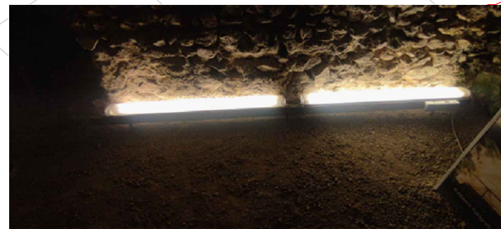
TALLAR PERFILS "L" I DESPRÉS SOLDAR SOPORTS PER A LES TIRES LED
