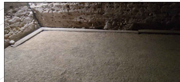
RETIRADA DE CANAL DE FERRO EXISTENT
