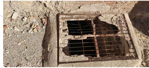
DEMOLICIÓ DE REIXA I POSTERIOR REPOSICIÓ AMB TRAMEX
