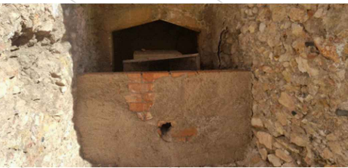
DEMOLICIÓ DE MUR I DE VENTILADOR EXISTENT, I POSTERIOR INSTAL·LACIÓ DE NOU VENTILADOR, I COBRIR AMB MALLA
