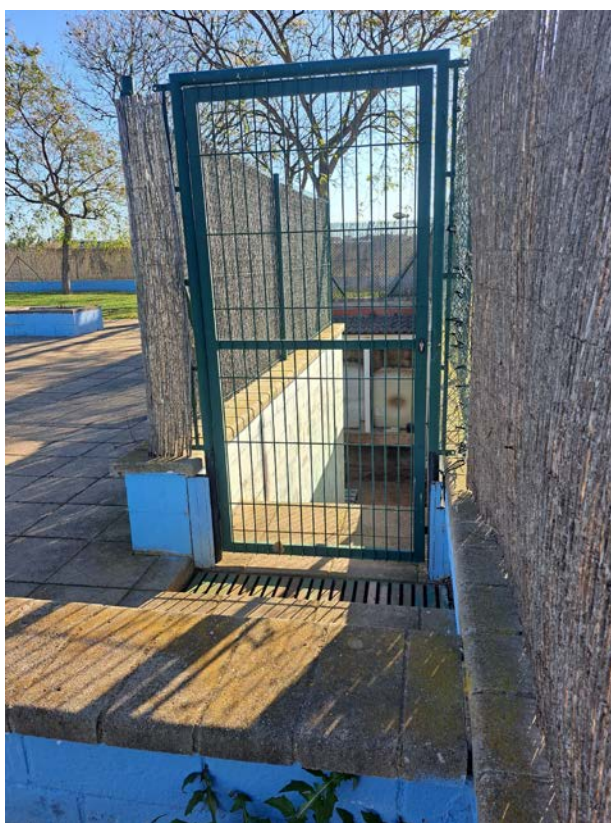
2. Piscina municipal. Vista de l'accés superior a la sala de maquinària i tractament
