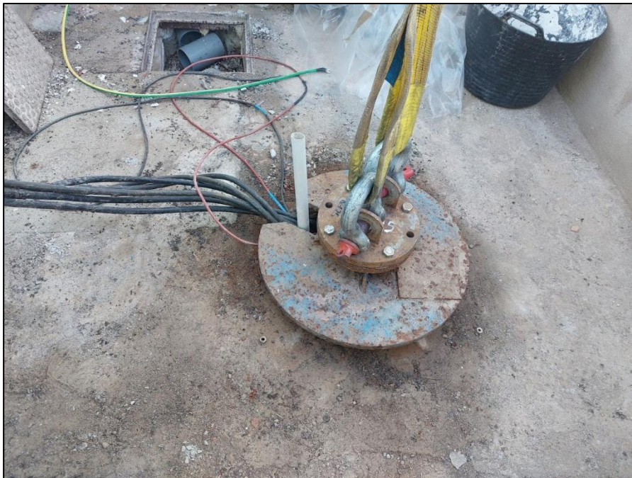
Imatge 3. Brida amb ganxo per l'extracció del muntant.
