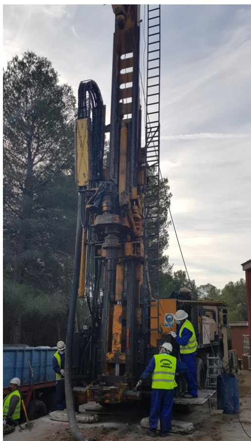
Imatge 5. Exemple d'equip de rotació
