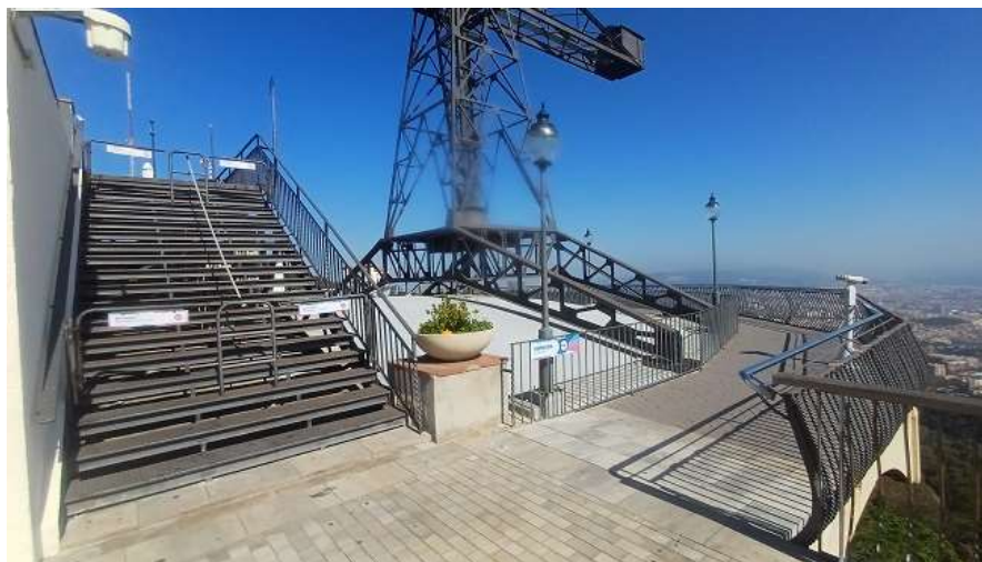
06 LOT 1 NIVELL 6 accés avió 2 mirador
