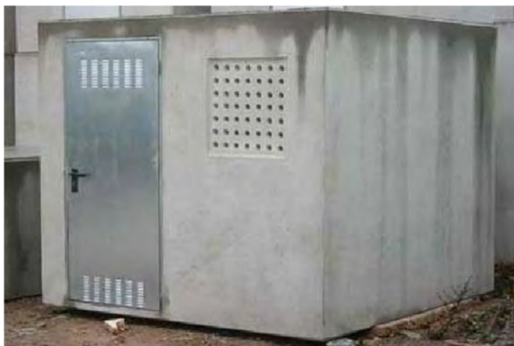
Detall caseta prefabricada de formigó de Tehorsa (o similar)
