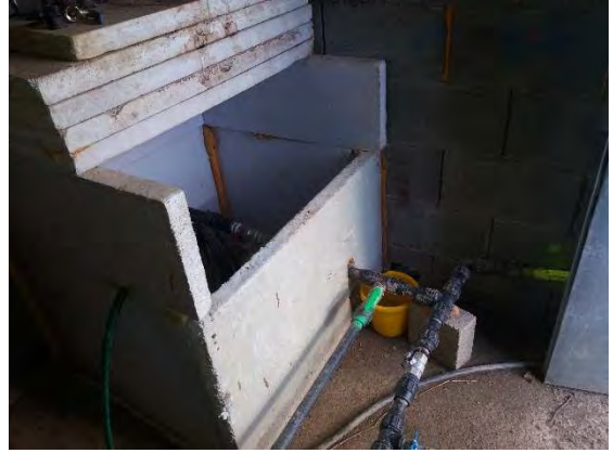
Foto 4: Arqueta pou en interior caseta
