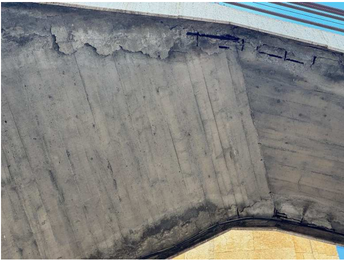
Vistes de les lloses d'escaleres carbonatades i armadura oxidada
