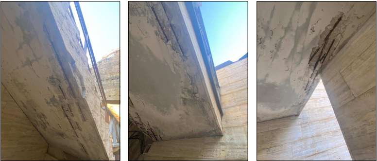
VISTES DE L'ESCALA D'ACCÉS AL MUSEU DESDE LA PART INFERIOR PER VEURE L'ABAST DE LES PATOLOGIES EN LES LLOSES D'ESCALA
