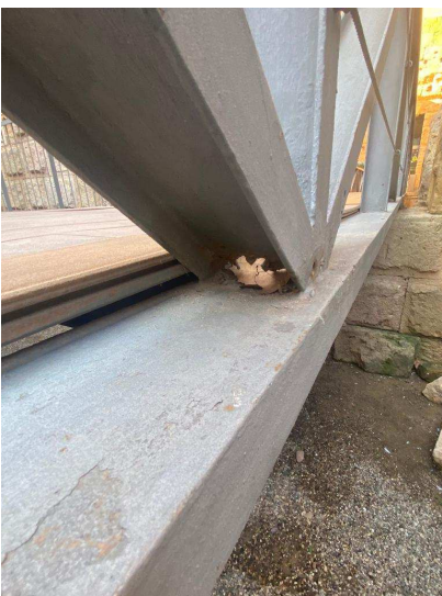
Vista dels nusos oxidats de la passera i bases de suport
