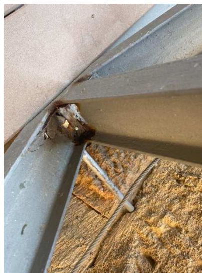
Vista dels nusos oxidats de la passera i bases de suport
