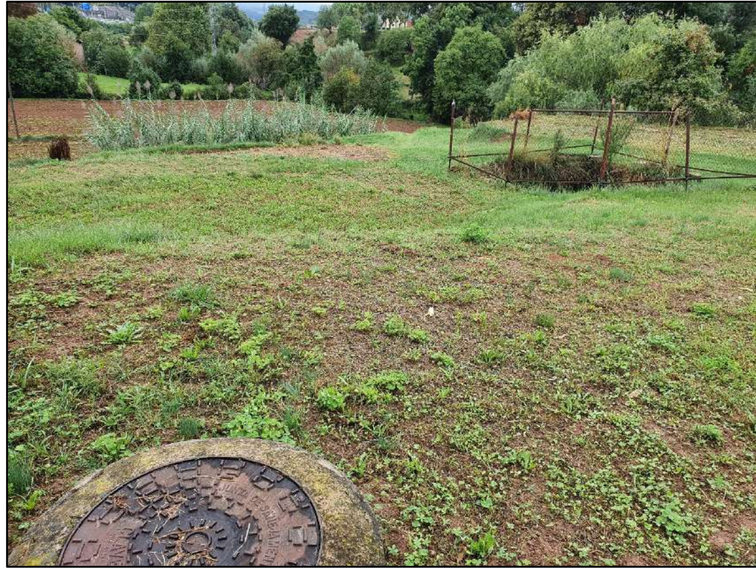
Imatge 1. Vista PK 0+000. Pou 94. Construcció de nou sobreixidor
