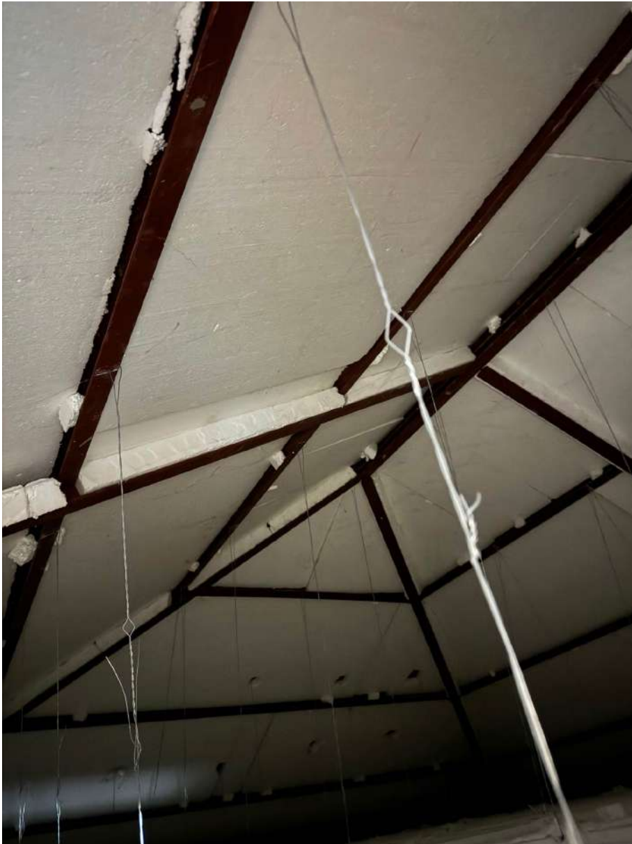
Imatge de l'estructura de la coberta del cos central.
