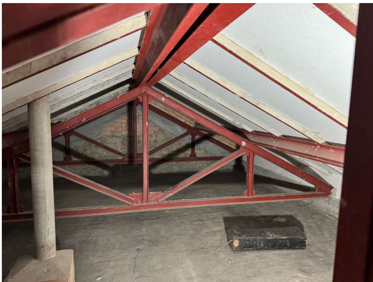
Imatge de l'estructura de la coberta dels cossos laterals.
