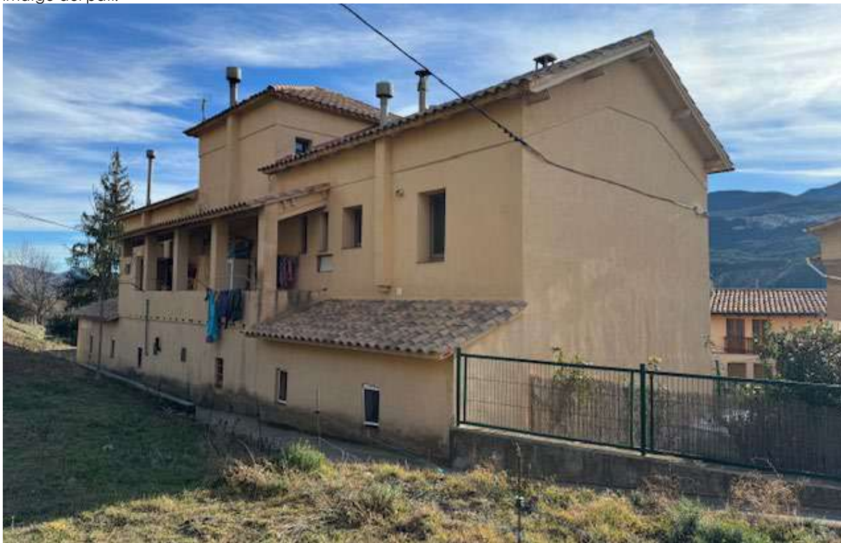
Fotografia de l'immoble. Façana posterior. Es pot veure l'accés des del carrer Serra d'Ensija.
