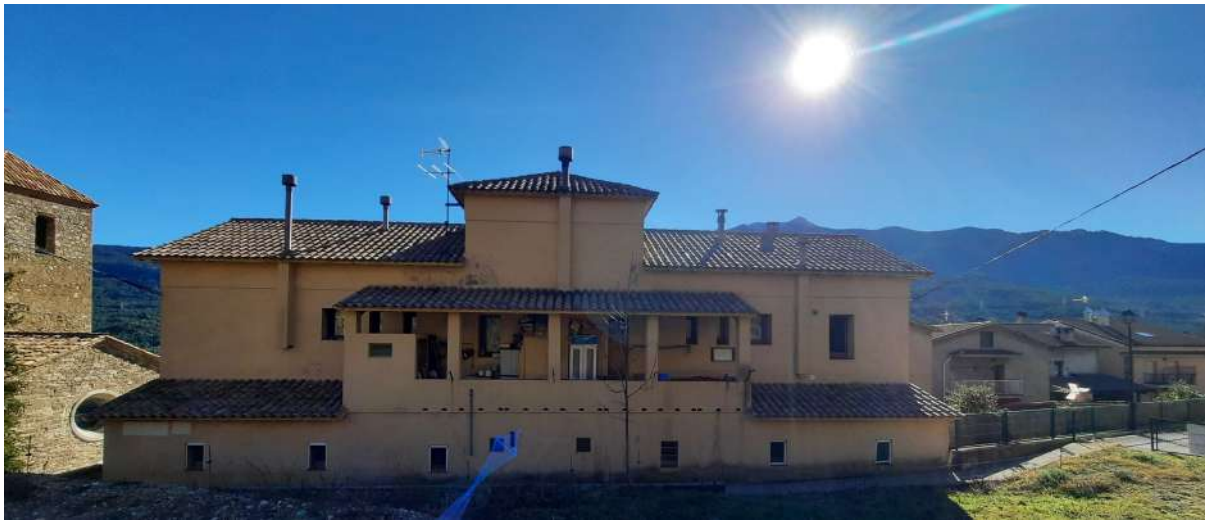
Fotografia de l'immoble. Façana posterior.
