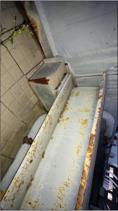
Imatge: Estat actual - Recoizament
