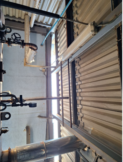
SOSTRE I ESTRUCTURA A DESINSTAL·LAR I REFER
