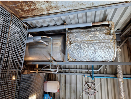
DIPÒSITS DE CONDENSATS I PURGES A DESINSTAL·LAR AMB LES SEVES CANONADES. INSTAL·LAR NOUS DIPÒSITS.
