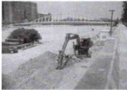
DEMOLICIÓN MECÁNICA A CIELO ABIERTO
